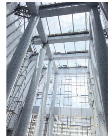
Hình 2.2b: Hình ảnh thi công sản phẩm
